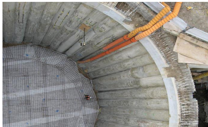
Fig 1 Secant piles
